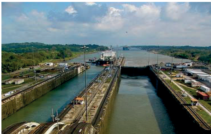
Сл.6.2. Бродска преводница, каде земјениот притисок на потпорните ѕидови е во состојба на мирување
