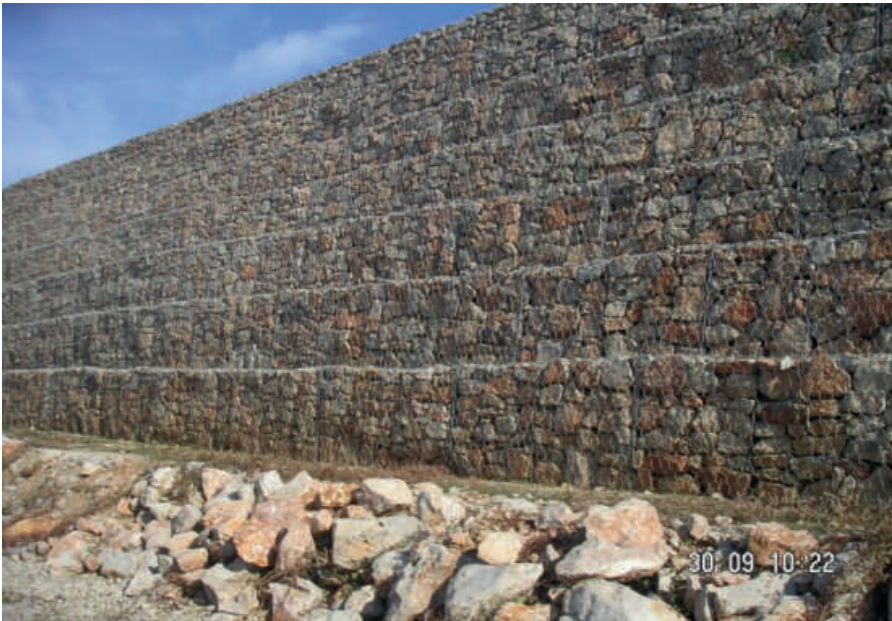
Сл. 6.1. Потпорен сид од порозен материјал-габиони
