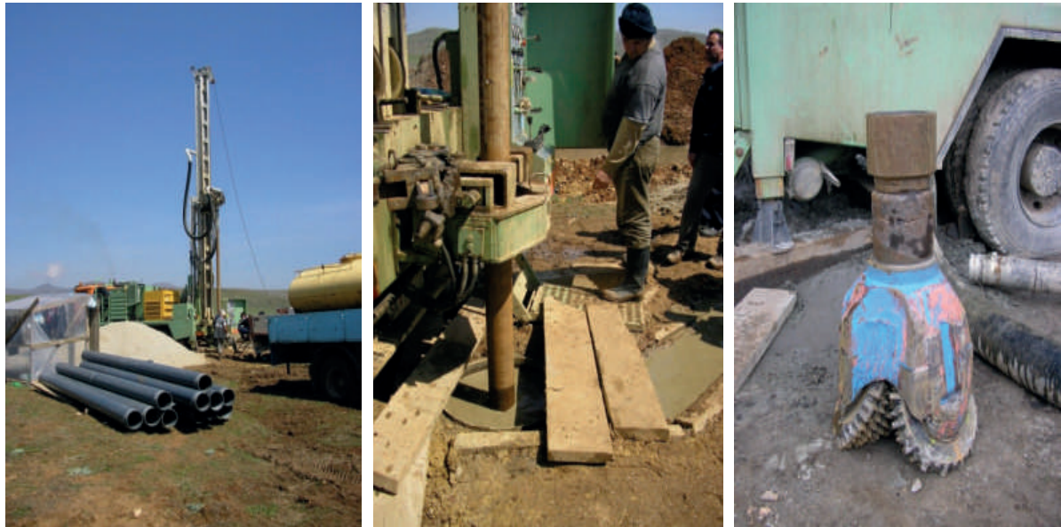
Сл. 4.8. а-Комплетен прибор за дупчење бунари, б-деталъ во зона на глава на машината и в- длето за дупчење
